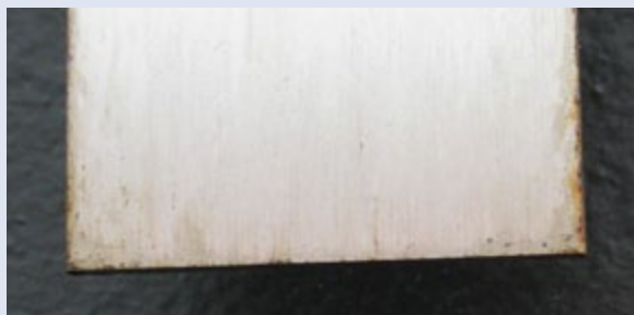
Overfladiske grubetæring i syrefast 4404-stål som følge af havsalt. Risikoen for funktionssvigt er meget ringe, og skaden er derfor mest af kosmetisk karakter.
